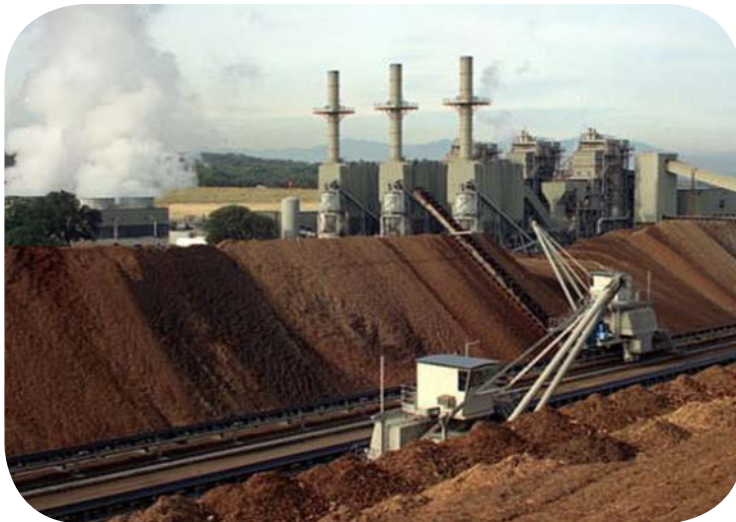
شکل (۷) نیروگاه چوب سوز ۴۹ مگاواتی در اندرسون کالیفرنیا، تاریخ بهره برداری ۱۹۹۶
